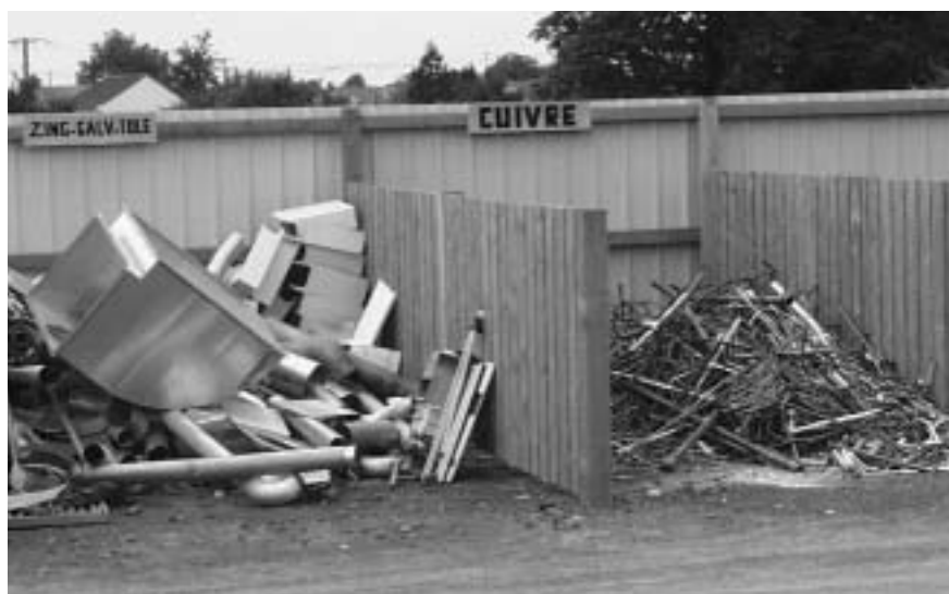
Tri sélectif des déchets sur un chantier.
