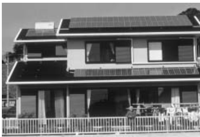
Maison équipée de panneaux solaires photovoltaïques (production d'électricité) et de panneaux solaires de production d'eau chaude.
